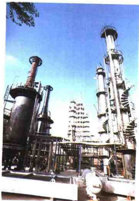
◇ 银行贷款支持兴建的50万吨常减压炼油塔
