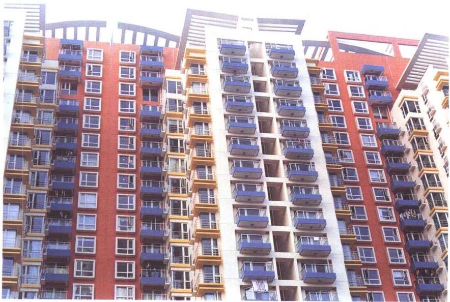
彩图 1.01 采用涂料作外饰面的住宅楼宇工程举例(一)
