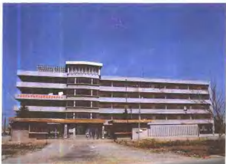
△ 连云港市职工技术培训中心综合教学楼
