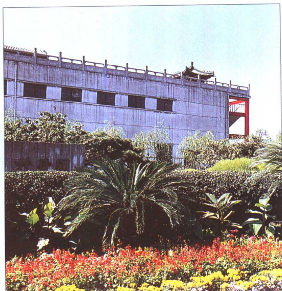
5 某厂装饰美化泵房, 使其成为了园林景点
