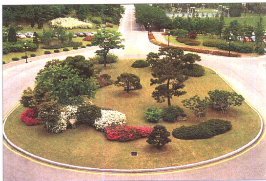
11 某厂道路交叉处的环岛留出了必要的安全视距
