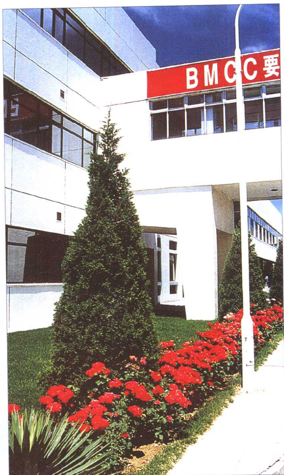
21 某厂精密仪器车间门口的绿化
