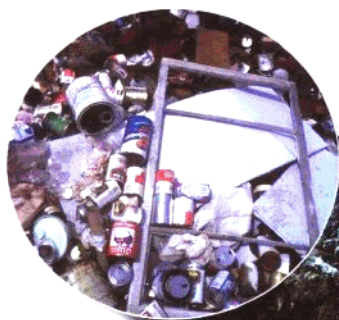
△堆满垃圾的建筑工地
