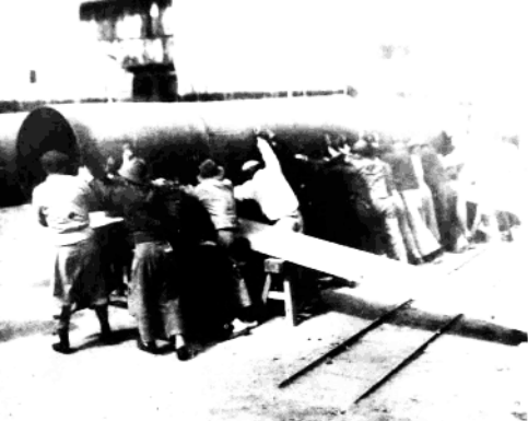
1931年，英商杨树浦水厂工人在搬运直径40英寸1000毫米钢管
