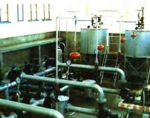
晋县石油公司轻油泵房
