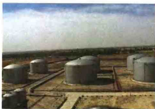
保定石油公司南库 金属罐区一角
