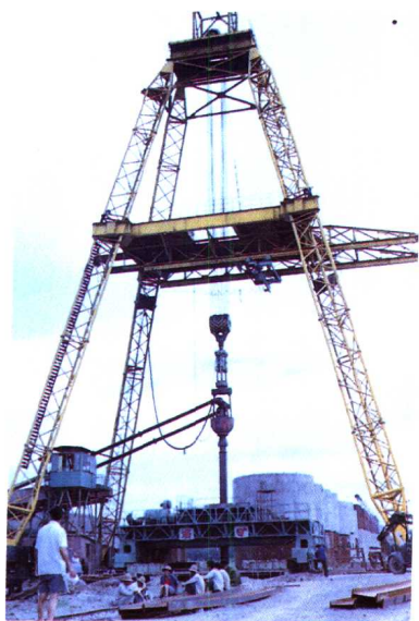
◀ 图 15—1 煤矿竖井钻井法凿井施工现场
