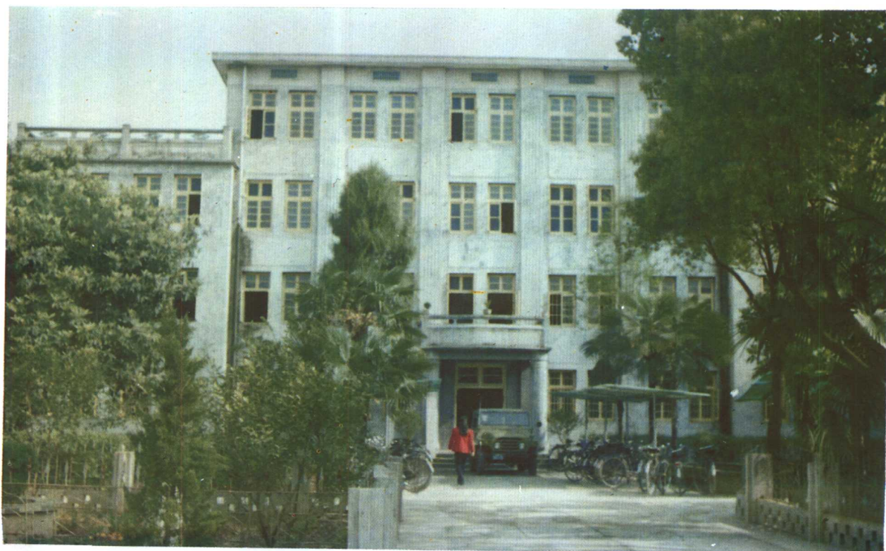
● 中共东至县委办公楼
