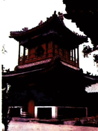
礼拜寺院内邦克楼 (唤拜楼)
