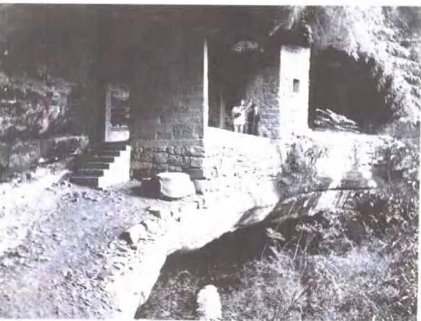
▲ 楼上楼 程伟仁摄
