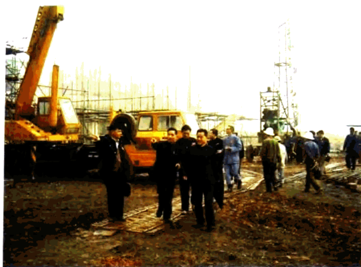
副省长梁凯轩视察江西水泥厂扩建工程
