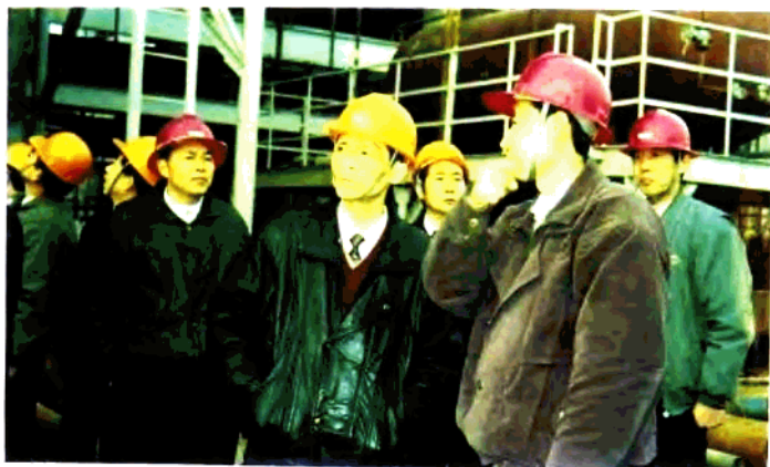
副省长黄智权深入九江化工厂环氧丙烷工地了解工程进展情况
