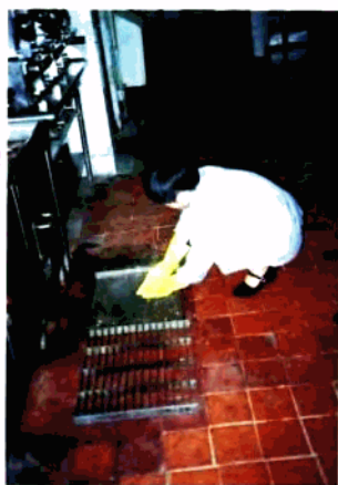
图23 厨房水道加防鼠板，下面再 加一层滤网，便于及时清除 污物，并具有防鼠、防蝇、 防蟑多重功效。
