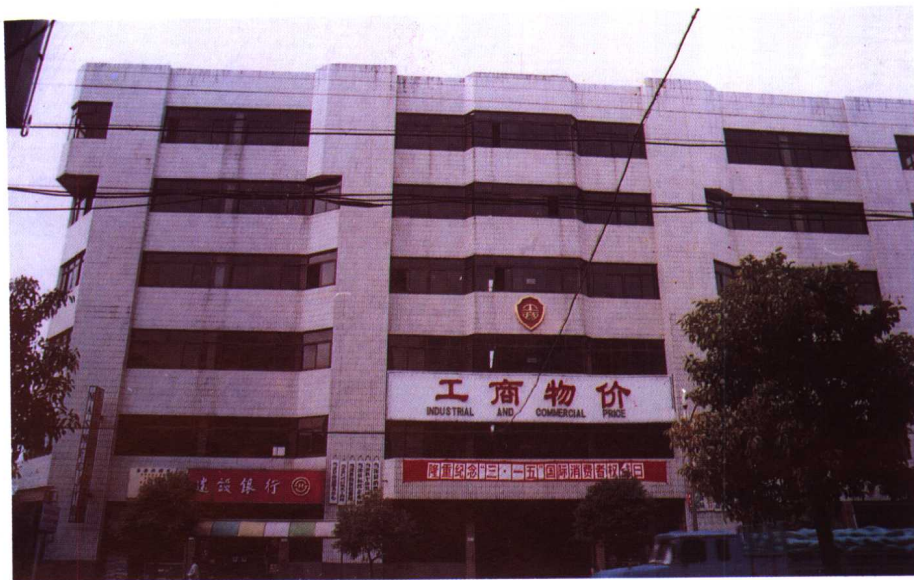
▲座落在当涂城关提署路540号县工商局办公大楼
