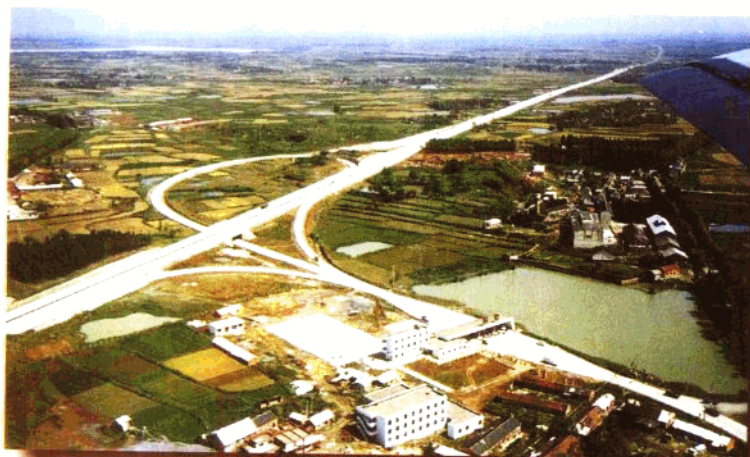
合宁高速公路全椒入口处鸟瞰
