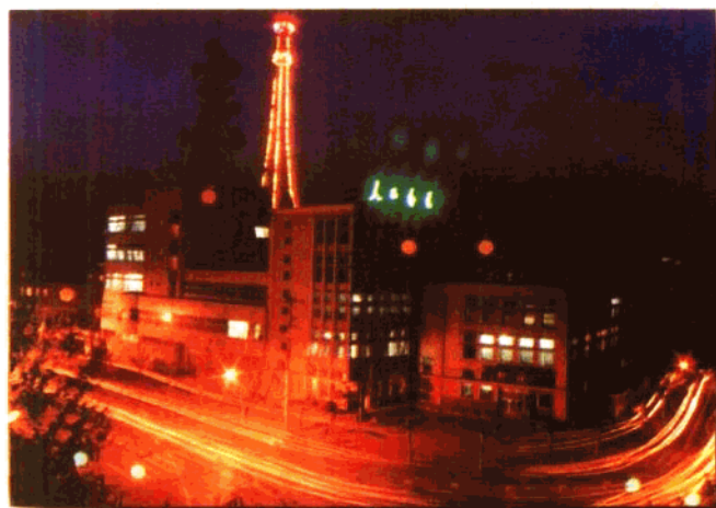
滁州邮电大楼
