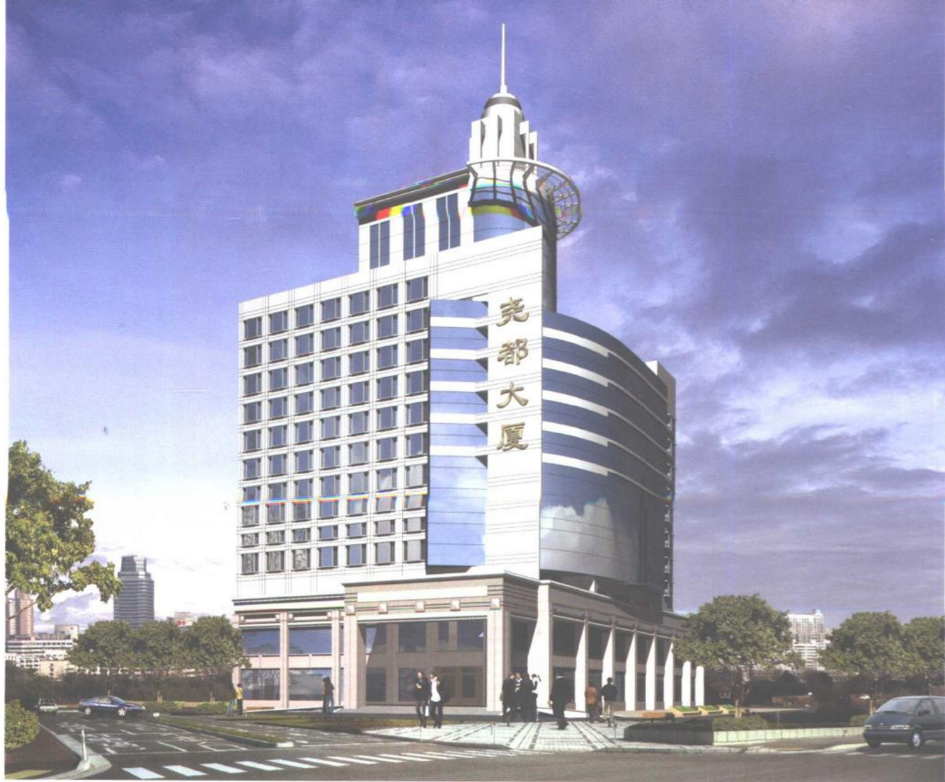
天津尧都大厦外观
