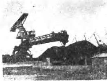
宁波港镇海港区煤炭堆场斗轮堆取料
