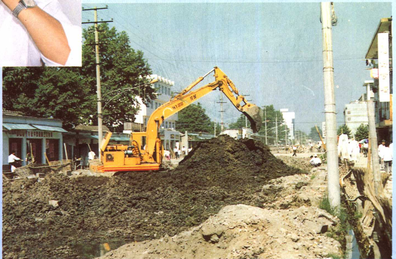
图为施工中的舒城城关镇龙舒路混凝土工程
