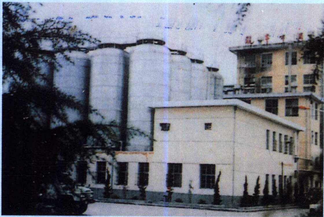
生产车间外貌
