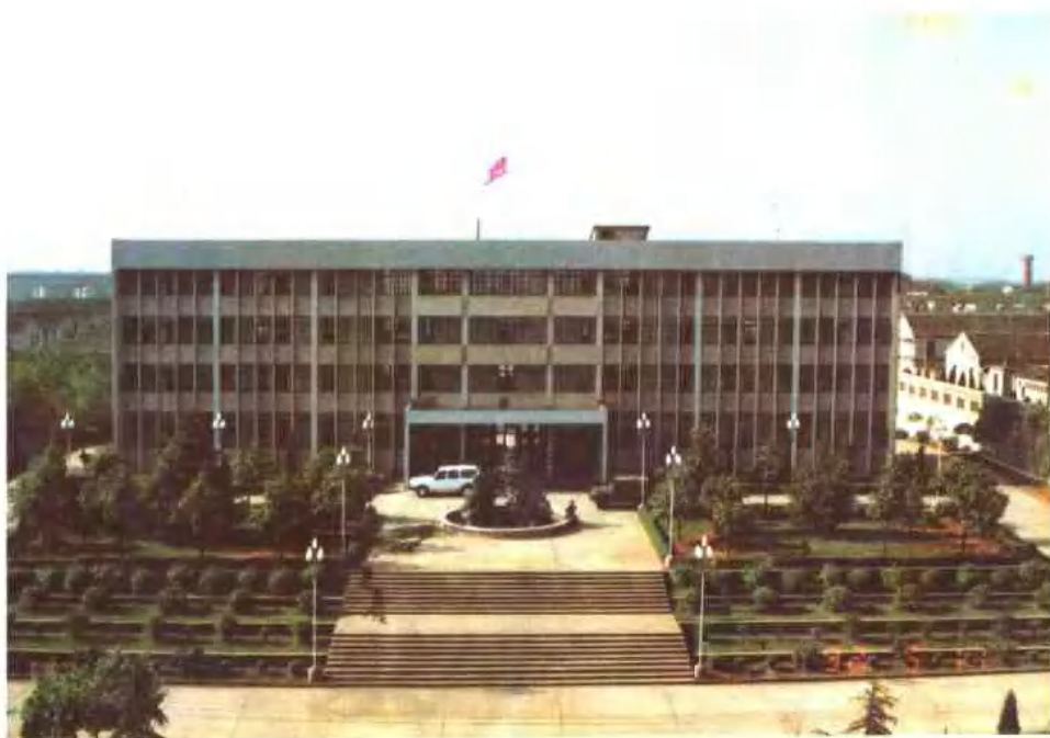
芜湖县人民政府办公大楼
