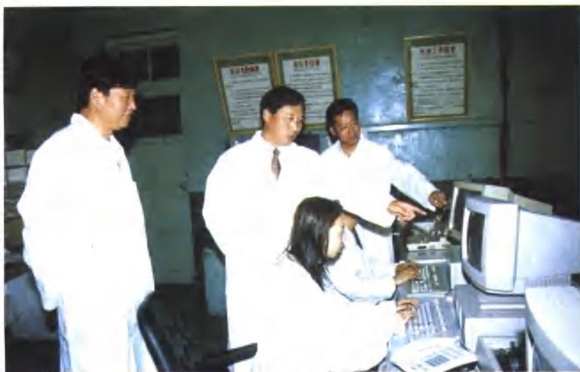
舞钢市邮电局新任局长何路德（左二）深入微机房检查程控电话设备运转情况
