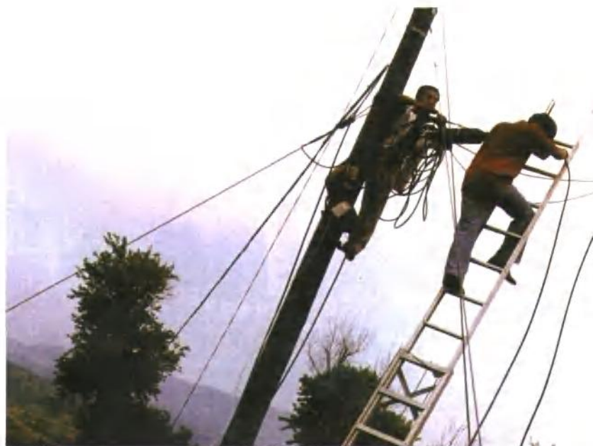
平顶山市邮电局员工紧张布设电缆，实施农话“杆线到村”工程
