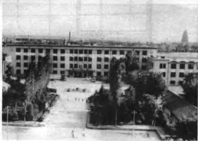
1960年学院自己设计，施工的行政办公楼。 (右上角远景为大雁塔)
