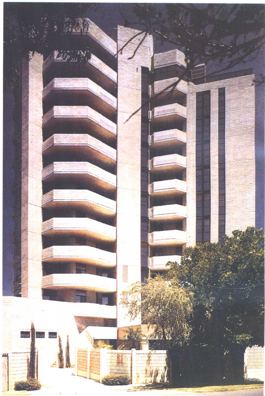
图4 澳大利亚小砌块高层建筑
