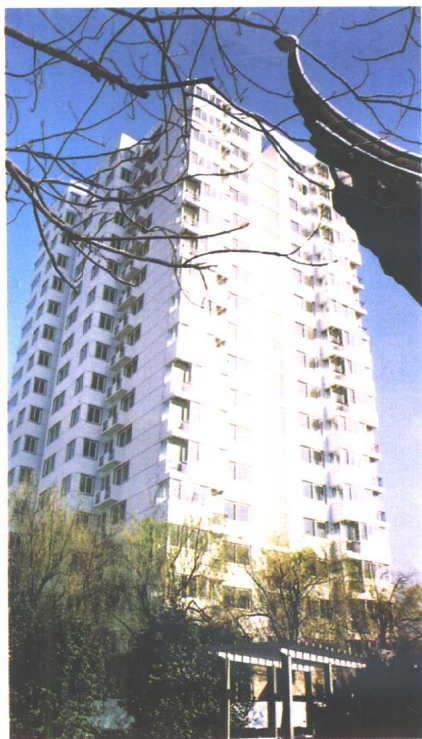
图10 上海18层小砌块住宅楼
