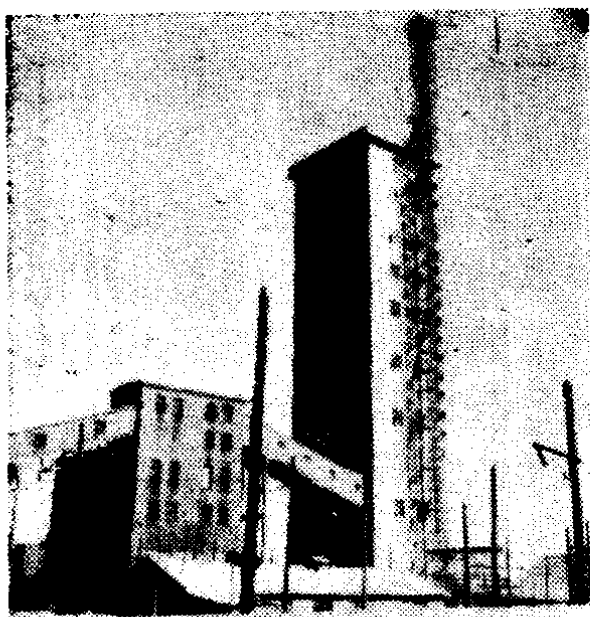
图 0-1 石咀山二矿主井井塔
