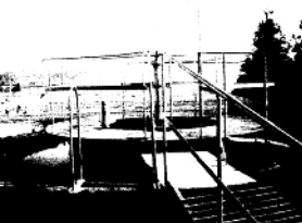
龙场水厂改进型水力循环澄清池
