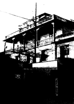
市卫生局办公大楼
