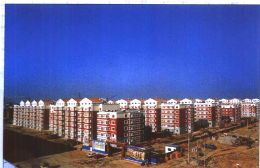
南磨房乡田华建筑四公司承建的回龙观小区教师楼工程
