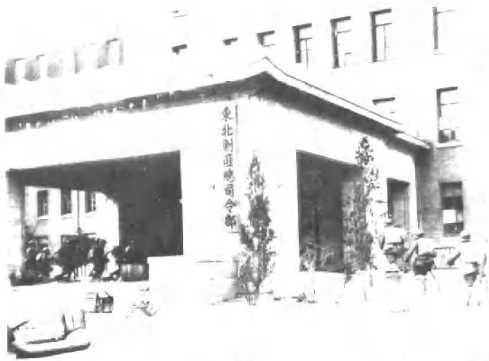
一九四八年十二月一日，解放军 攻进国民党东北「剿总」司令部大楼 (现为沈阳铁路局办公楼)
