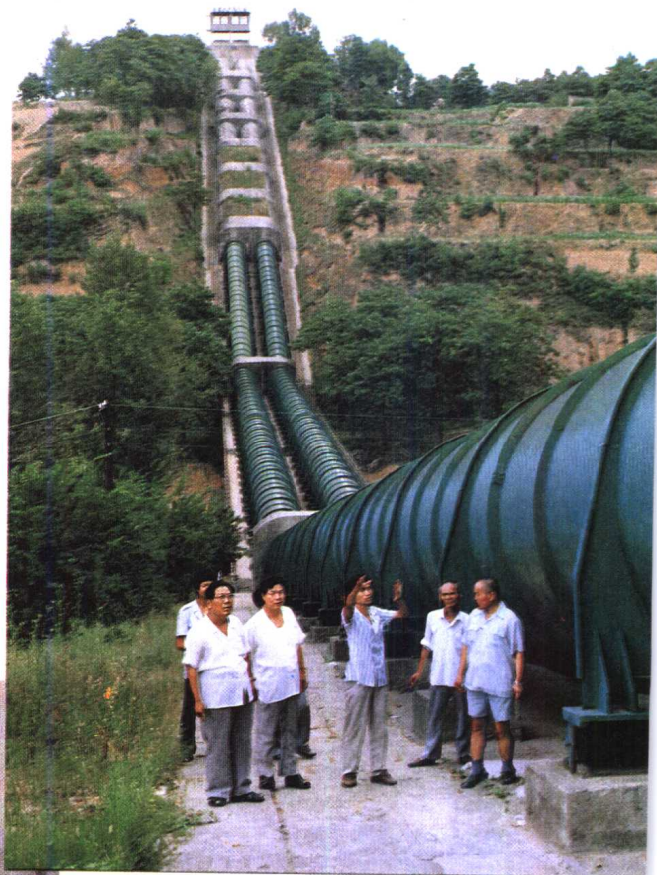
农业银行贷款支持的 宝鸡峡引渭工程中的 倒虹工程建设。
