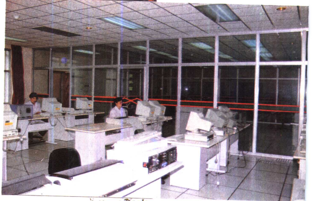
人民银行系统 电子计算机机 房一角。
