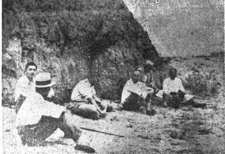
李仪祉先生（右第三人）在洛惠渠工地。
