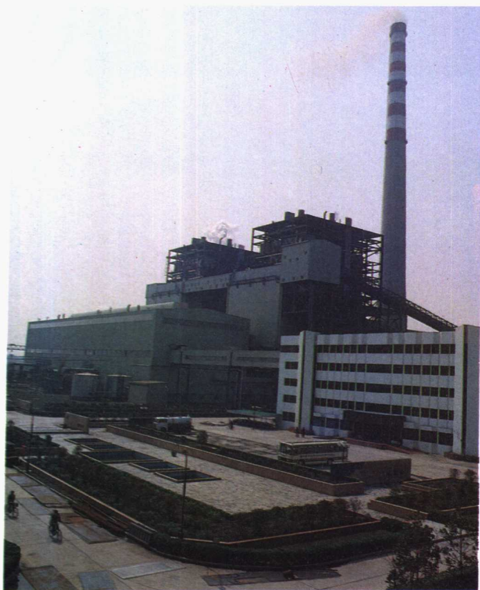
▲ 华能南通电厂全景(装机容量70万千瓦)
