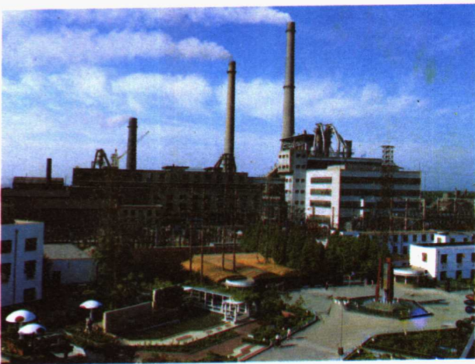
▲ 盐城发电厂全景
