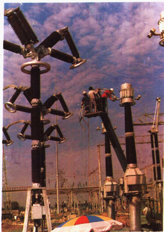
▲ 500千伏江都变电所设备安装
