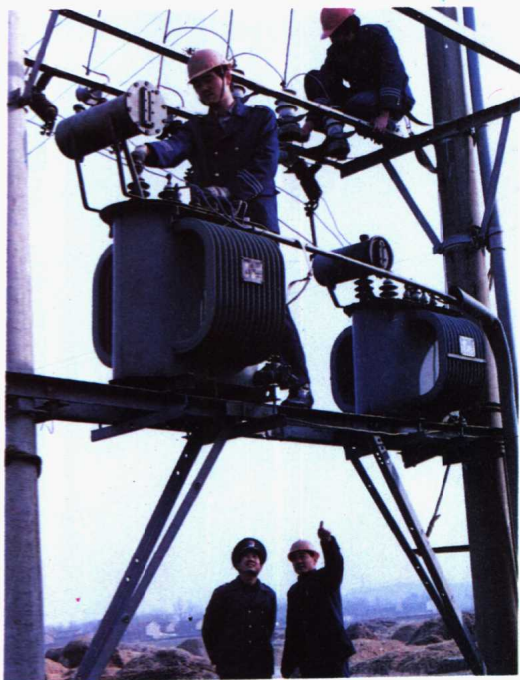
▲ 全省第一个用电标准化县——铜山县在检修青山泉乡配电变压器
