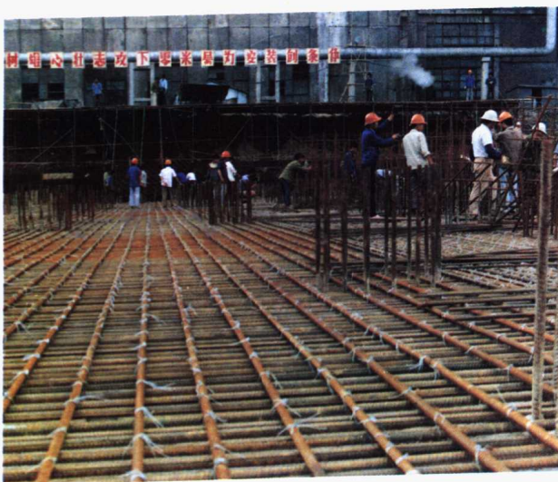
▲ 华能南京电厂1号机组基础施工
