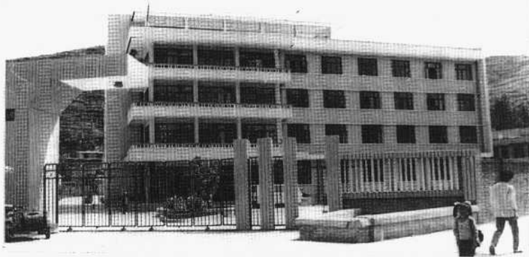
毕节养护总段大楼
