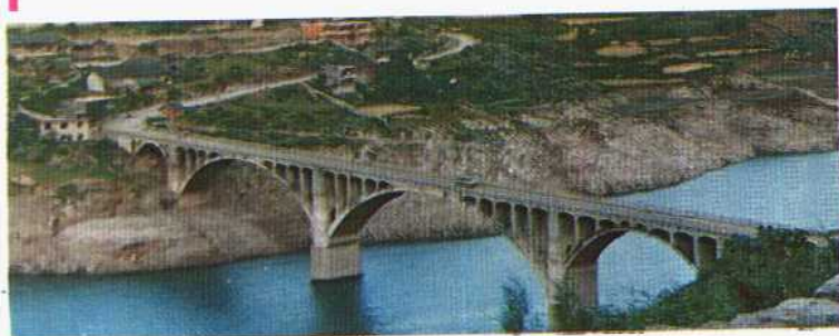
三杨公路沙三大桥
