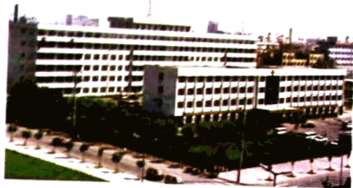
市第一人民医院全景
