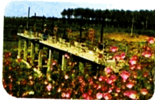
盘锦市二道桥防洪闸
