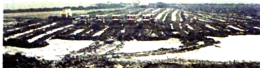
京沈高速公路盘锦段施工现场
