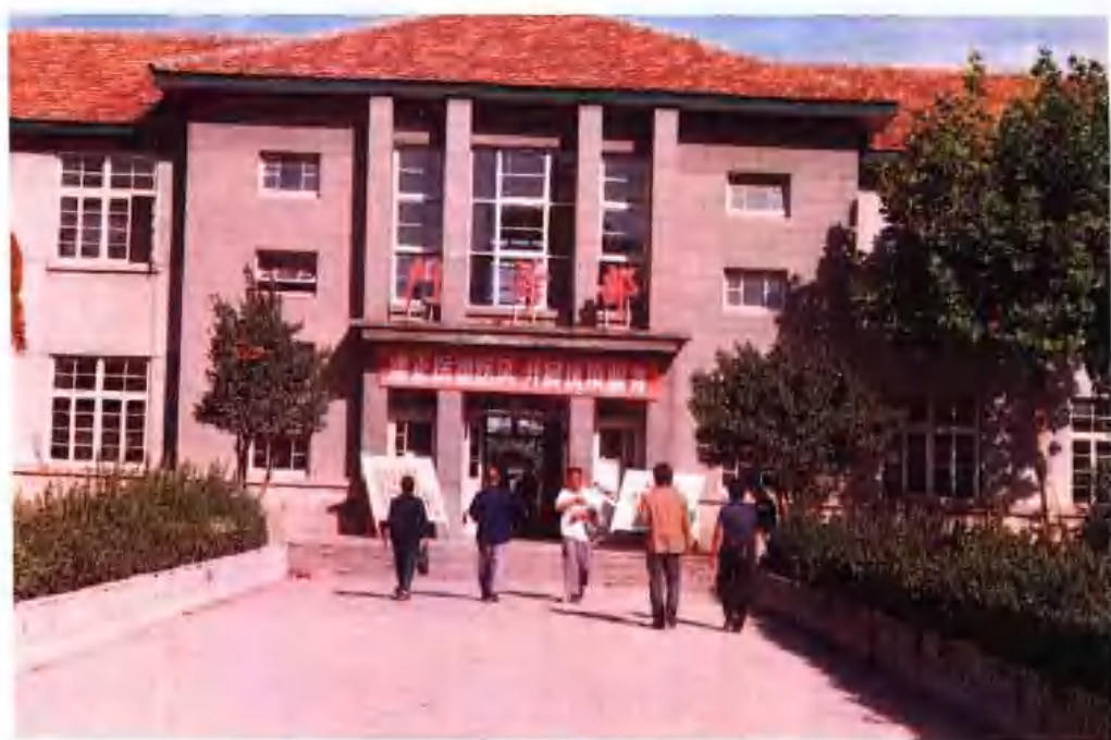
市二院门诊楼
