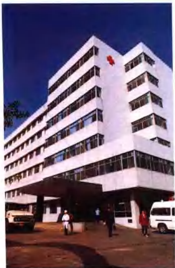
市一院外科病房楼
