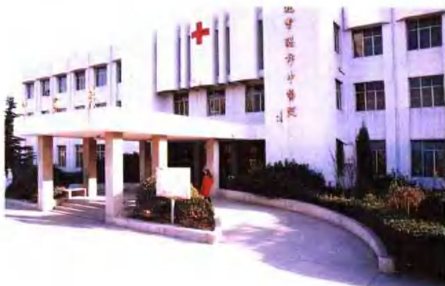
市中医院门诊楼
