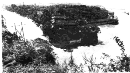
都江堰伏龙观
