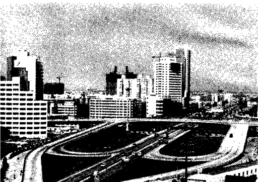
成都市人民南路立交桥
