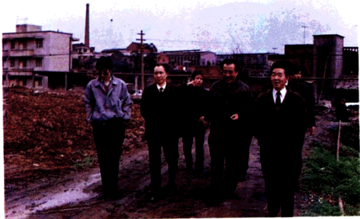
渝港钛白粉建设项目，是匡家 1992 年新开工的大中型重点工程，市农行对该项目给予了大力支持。图为牟森万行长（左二）陪同农总行工业信贷部付克恭主任（左三）视察钛白粉建设工地。
