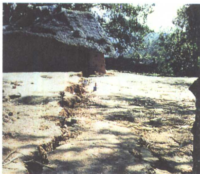
地震造成的地裂缝
