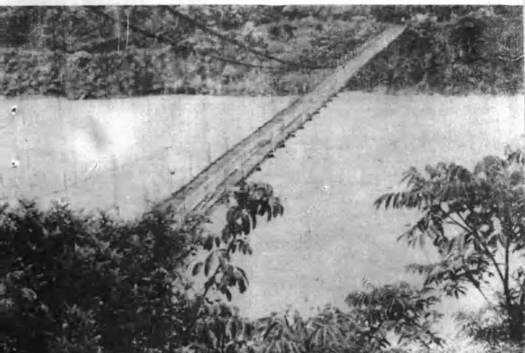
▲ 民主改革后在雅鲁藏布江上 架设的大型钢索吊桥
