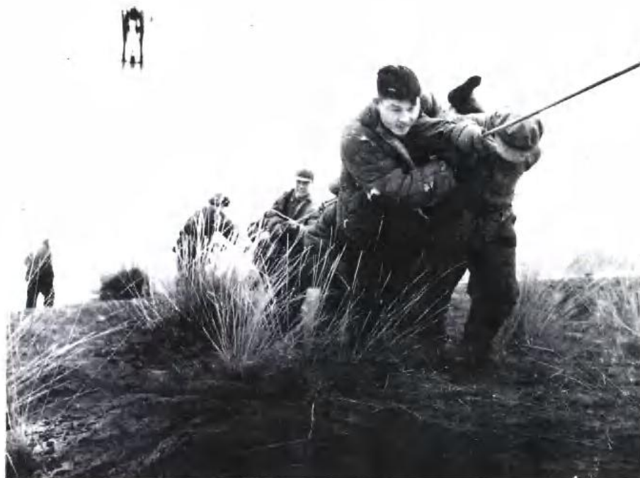
修井设备调往外油田后,职工人拉钢丝绳修井
