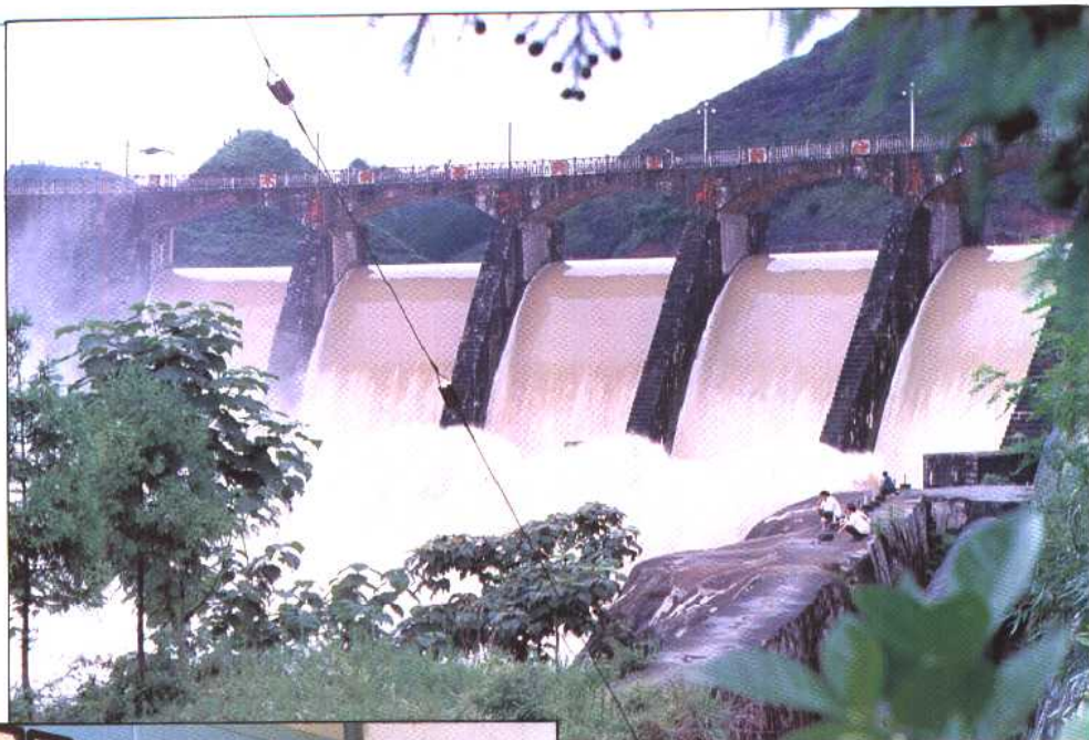
团结水库大坝
