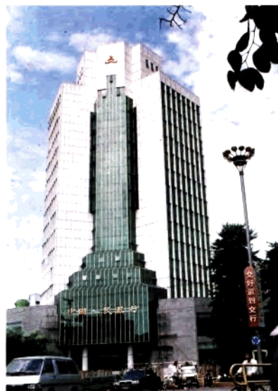
中国人民银行柳州分行办公大楼
