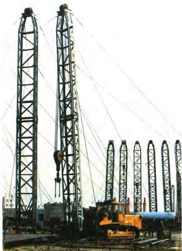
试油作业施工
