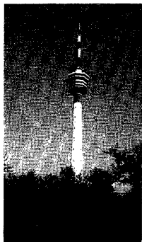
新建的陕西电视台发射塔
