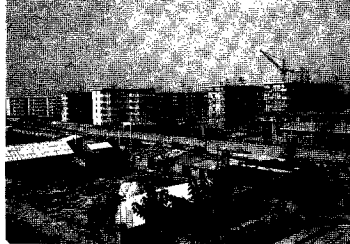
西安市西南郊建设中的电子城
