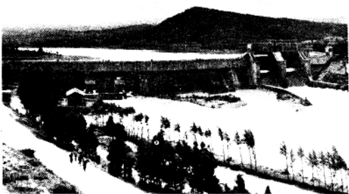
陆良县的一件水利枢纽工程——建在南盘江上的响水坝水库。
