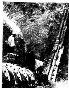
引阳宗海水灌溉 宜良坝子的英雄大沟 上的倒虹吸管。
