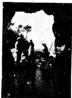
宜良县南冲大队开凿的 引水隧洞（长1700米）。
