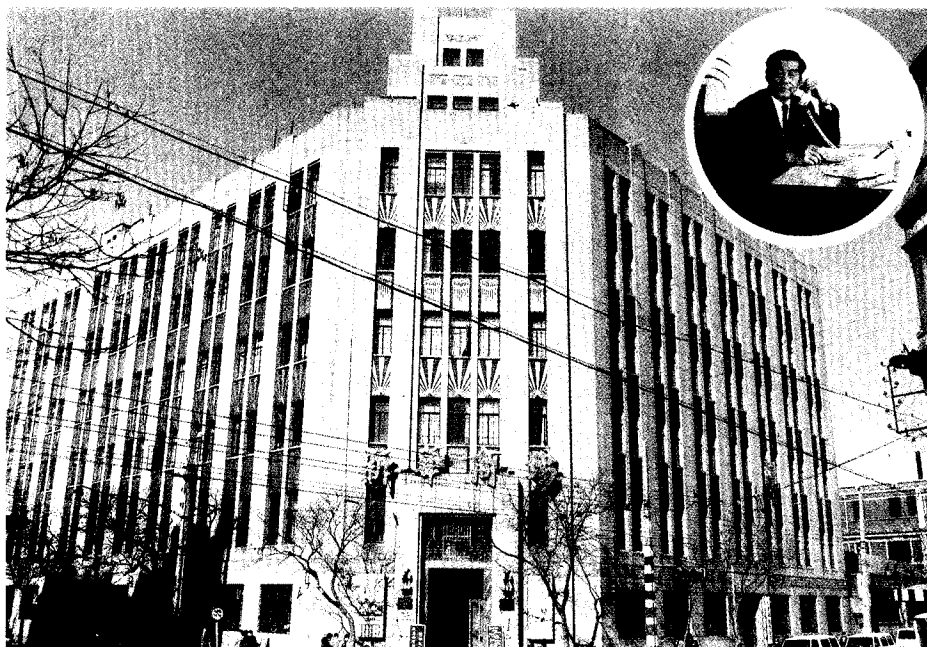
天津五金采购供应站办公楼 经理许建
