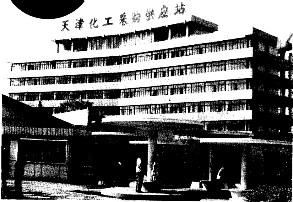
天津化工采购供应站办公楼
