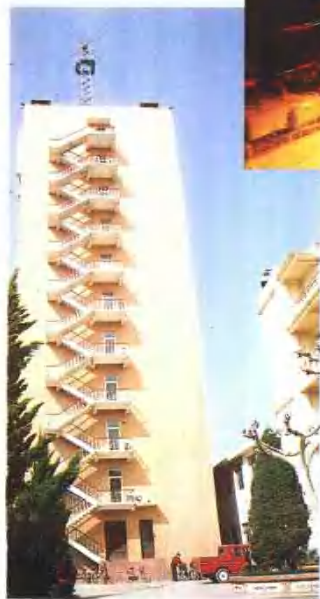
电业大楼一角
