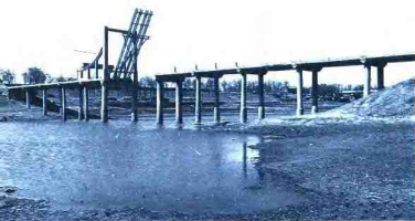
横跨大清河的文安县安里电旧桥
