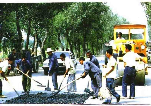
南县公路站在津保北线施工
