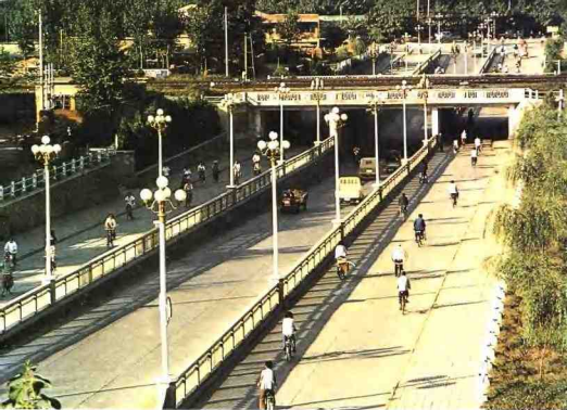
廊坊市内立交桥
