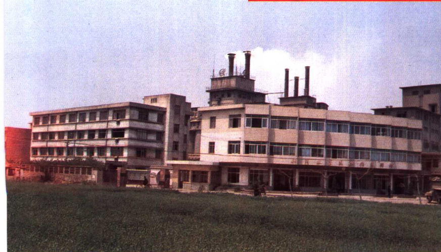
江阴水泥厂厂区
