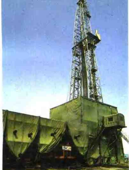
塔里木石油探台
