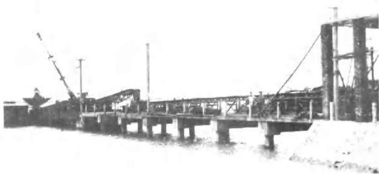
高港港原3号码头固定式皮带输送机
