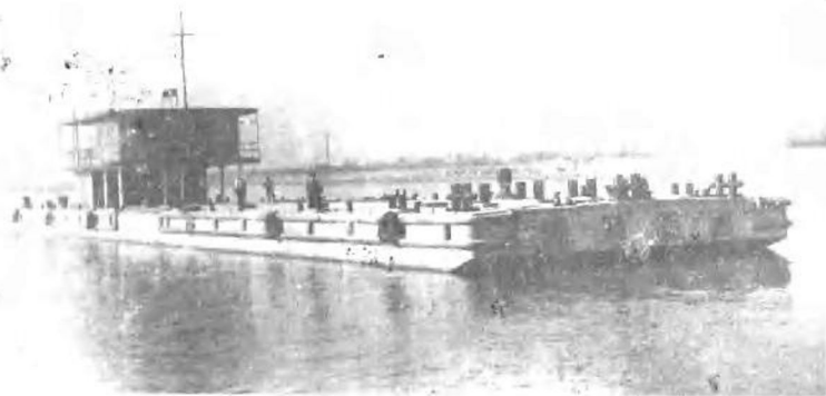
船厂生产的船型为65米的水泥趸船
