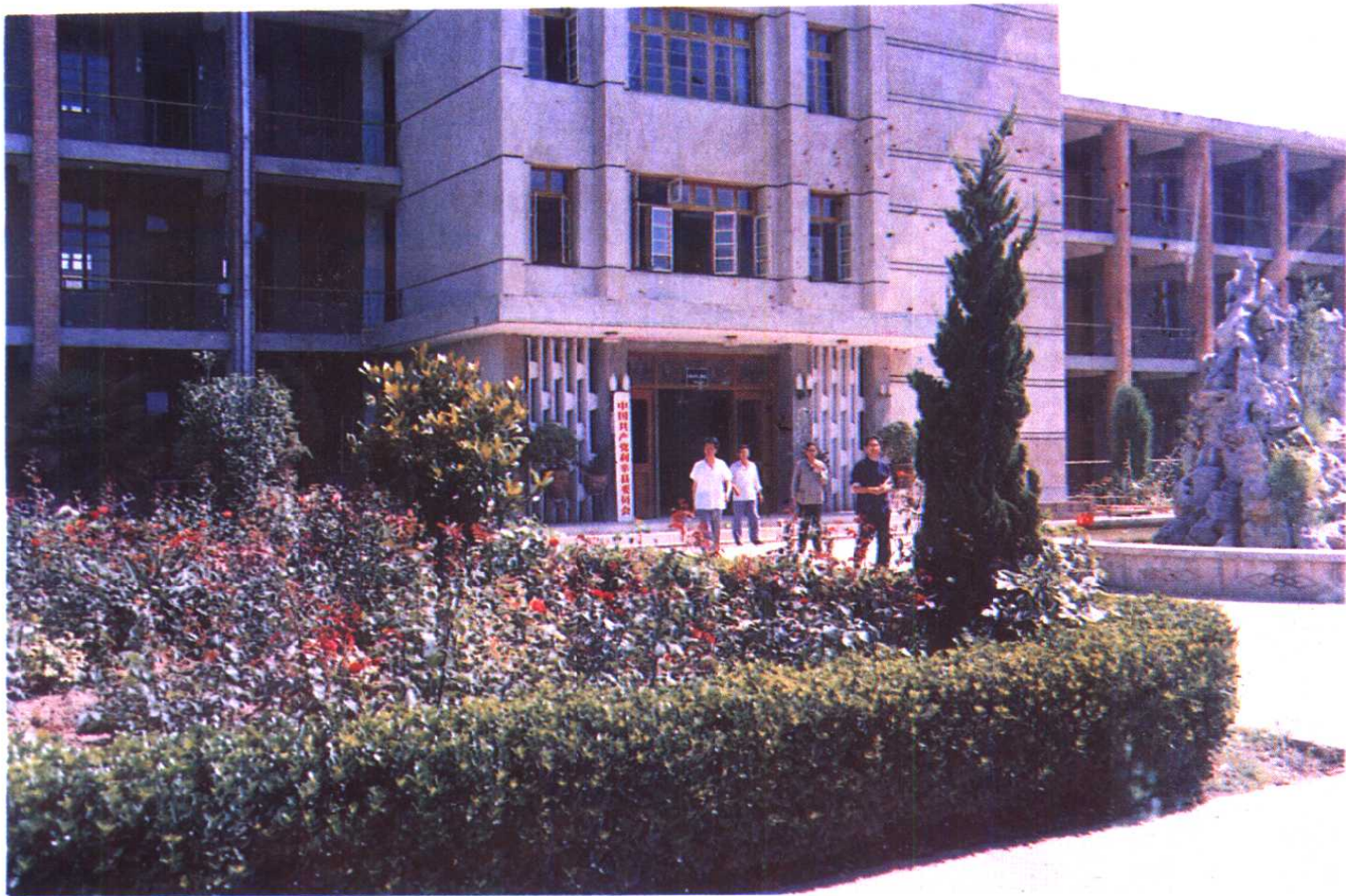
中共利辛县委办公楼
